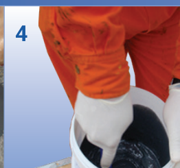
4 Preparación de resina epóxica bicomponente de 3X
