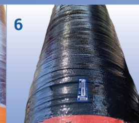
6 Recubrimiento protector y etiqueta inteligente
