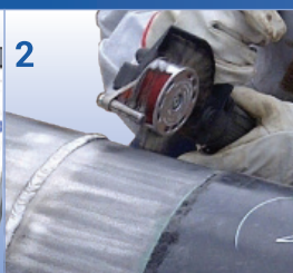
2 Preparación superficial Sa2½ / St3 y rugosidad Rz > 60 µmm
